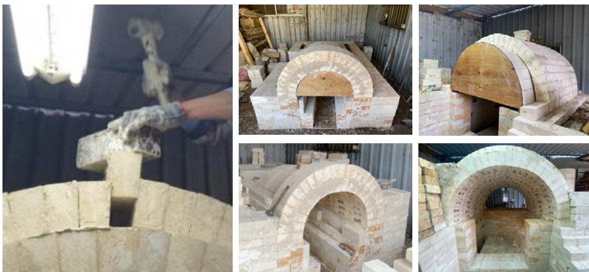
11 | 12 | 13 圖 11 窯拱閉合磚 (筆者拍攝, 2024/2/27) 14 | 15 圖 12 火膛窯拱砌斜磚 / 圖 13 窯室窯拱砌斜磚 (筆者拍攝, 2024/2/22 ~ 2/25) 圖 14 火膛拆模後 / 圖 15 窯室拆模後 (筆者拍攝, 2024/2/23 ~ 3/1)
