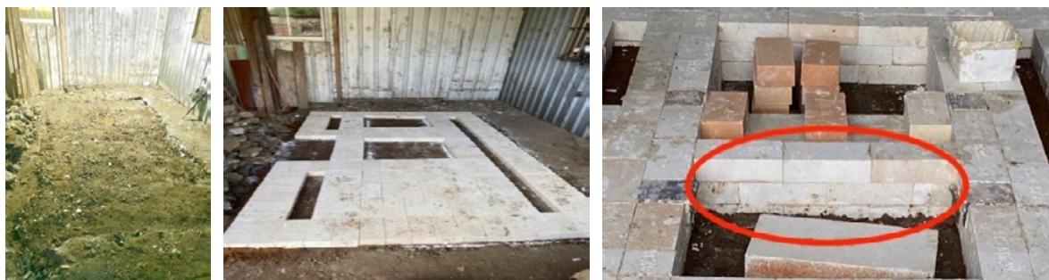
2 | 3 | 4 圖 2 窯基泥土地面 / 圖 3 窯基第一層 / 圖 4 每層要相互交丁 (筆者拍攝，2024/1/27 ~ 2/2)
