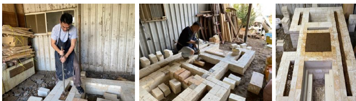
5 | 6 | 7 圖 5 內外牆間夯土 / 圖 6 窯床內夯土 / 圖 7 窯床夯土完成 (筆者拍攝，2024/2/4 ~ 2/6)
