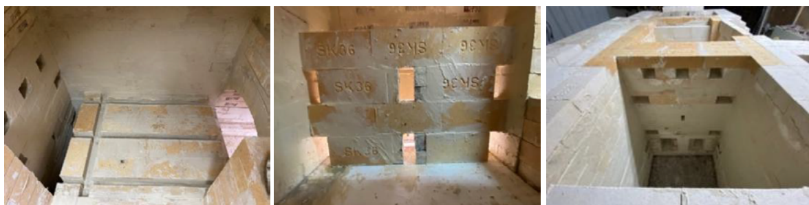
16 | 17 | 18 圖 16 窯床上方火路 / 圖 17 擋火牆火路 (筆者拍攝, 2024/3/6) 圖 18 窯體牆火路 (筆者拍攝, 2024/2/22)
