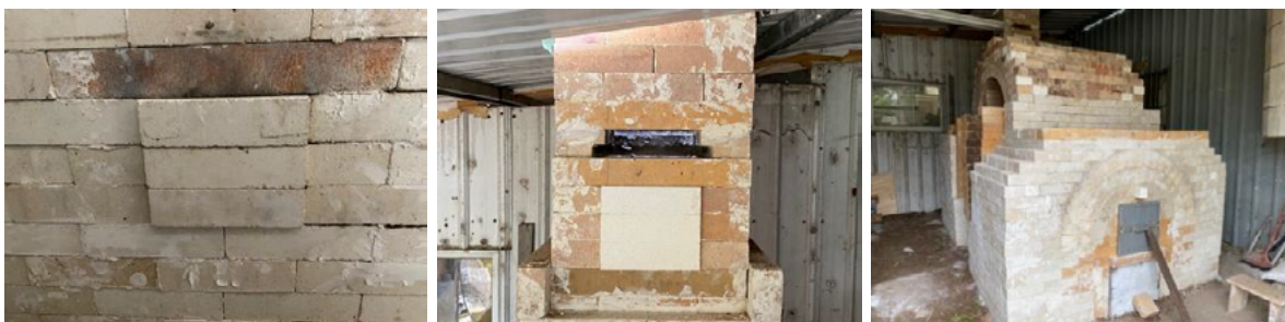
19 | 20 | 21 圖 19 窯後方煙囪下方抽磚處 (筆者拍攝, 2024/3/6) 圖 20 煙囪上方抽磚及插板處 / 圖 21 埤島窯完成 (筆者拍攝, 2024/3/15)
