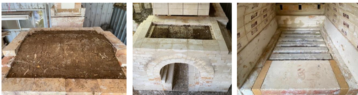
8 | 9 | 10 圖 8 窯室窯拱夯土 / 圖 9 火膛窯拱夯土 (筆者拍攝, 2024/2/23 ~ 3/6) / 圖 10 火膛爐柵 (筆者拍攝, 2024/3/8)
